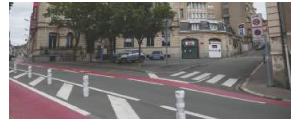
Aménagement de bandes cyclables rue Chanzy
