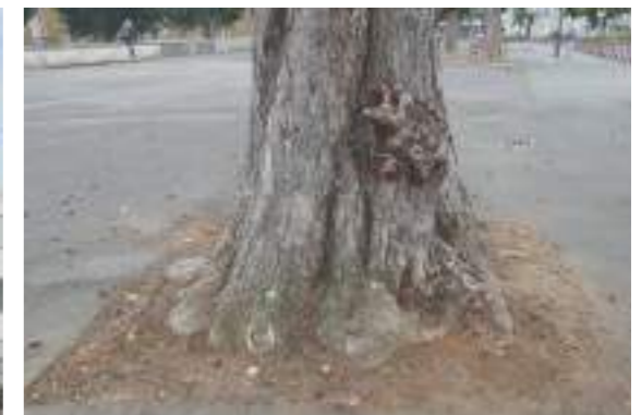
Les fosses de plantation deviennent insuffisantes et méritent une strate intermédiaire en pied pour conserver l'humidité et la perméabilité du substrat
