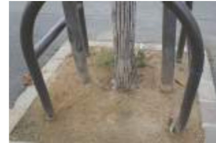
Un substrat compact et une fosse inadaptée
